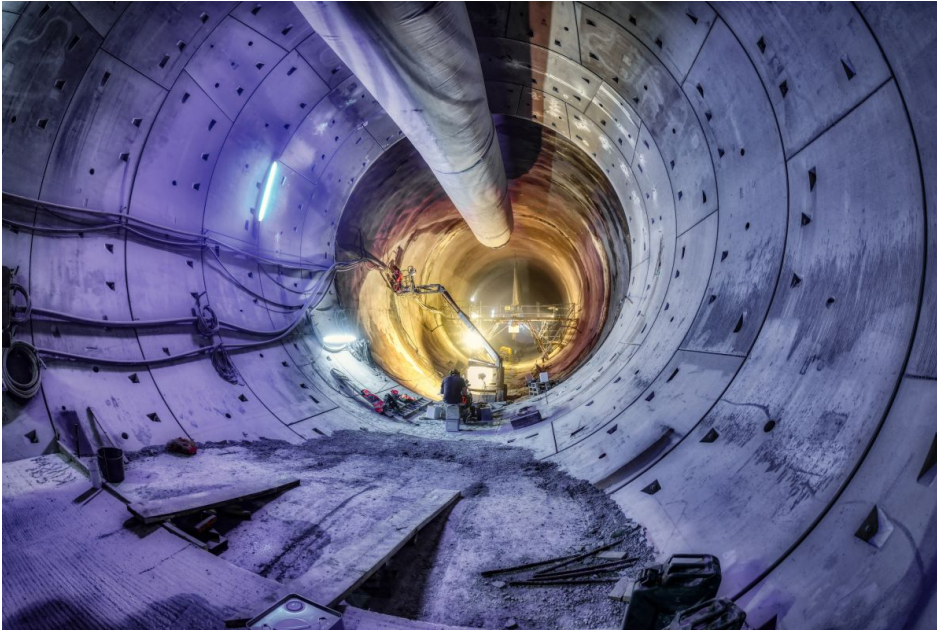
Bau des Fildertunnels in Stuttgart (Bild: DB AG/Arnim Kilgus)
