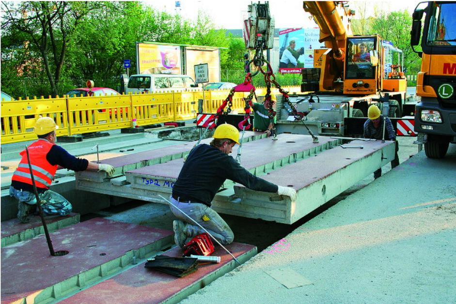
HGK Köln-Frechen: Aus gestalterischen Gründen erhielten die in der beengten Fußgängerzone verlegten frost- und tausalzbeständigen Befonfertigteileplatten durch eine entsprechende Matrize eine Oberflächenstruktur in Natursteinpflaster-Optik (Firmengruppe Max Bögl).
