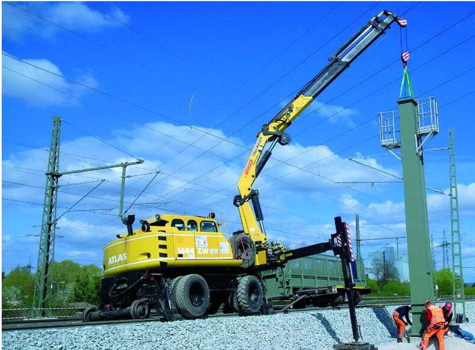
Ein Zweiwegebagger ist durch die BSB als Baggerkran umgebaut worden und stellt hier mit seiner Reichweite von 16 m Signaltechnik auf.
