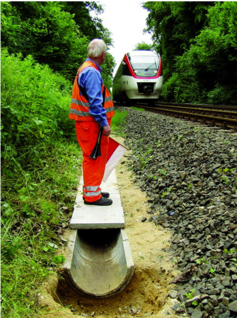
Porosit Drän-Versickerungssystem für den Bahnbau.
