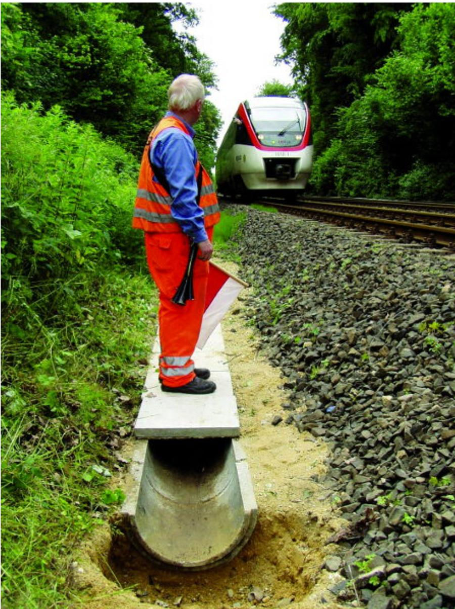
Porosit Drän-Versickerungssystem für den Bahnbau.
