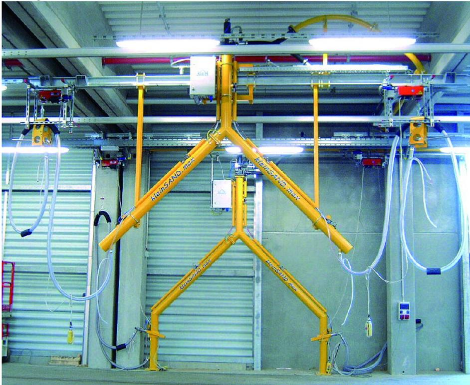
In einer Wartungshalle installierte Besandungsanlage mit kleinSAND.max-Stationen in Y-Form zum platzsparenden Besanden an zwei gegenüberliegenden Gleisen.
