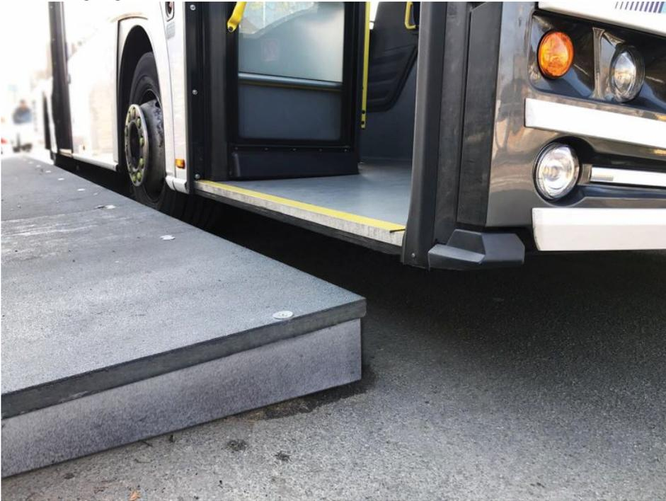
Vorgefertigte GFK-Platten (Elemente) für eine Bushaltebucht (Bild: Portner).
