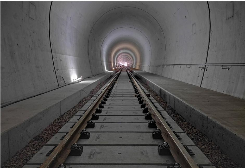
Fundament für den EuroTube: Auf Grundlage ihrer Feste-Fahrbahn-Technologie – hier die Eigenentwicklung IVES im Zierenberger Tunnel – möchte die Rhomberg Sersa Rail Group dazu beitragen, ein wirklich nachhaltiges Hochgeschwindigkeits-Transportsystem zu entwickeln (Bild: RSRG).
