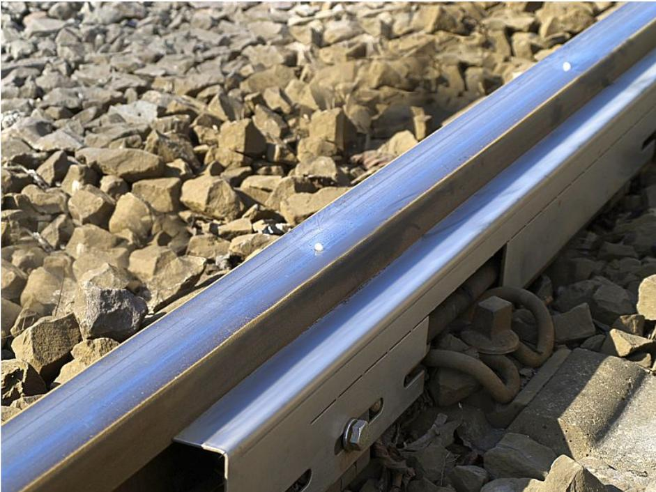
Die elektronische Schienenkopfbenetzung »SKBS« bringt fein dosiertes Schmiermittel durch spezielle Kanäle auf die Fahrfläche und benetzt die Schiene genau dort, wo die Reibung und damit das hochfrequente Quietschen entsteht (Bild: Moklansa).
