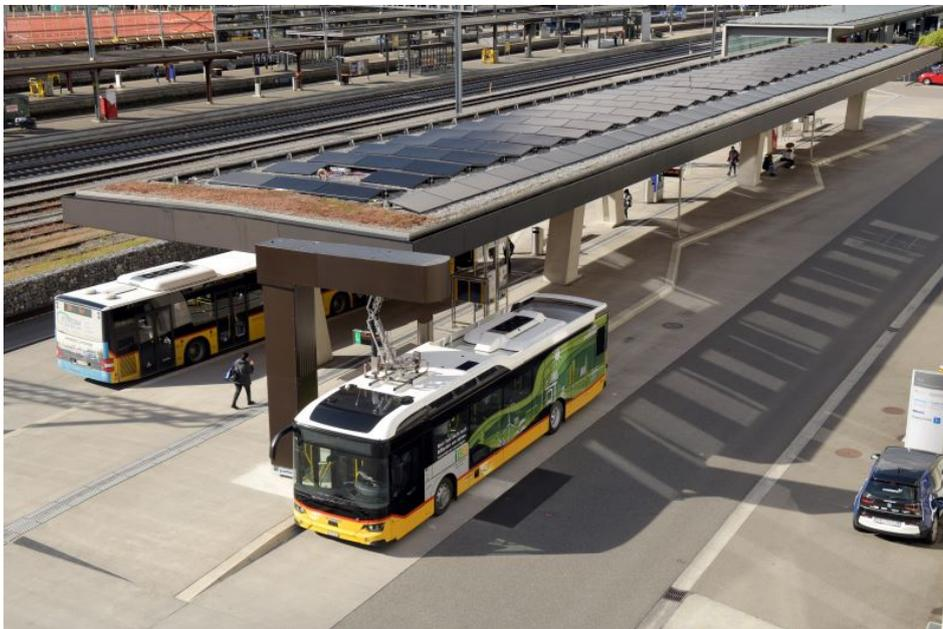
Das Postautoterminal mit PV-Anlage, Ladestation und E-Bus aus der Vogelperspektive gesehen (Bild: IBB Energie AG).
