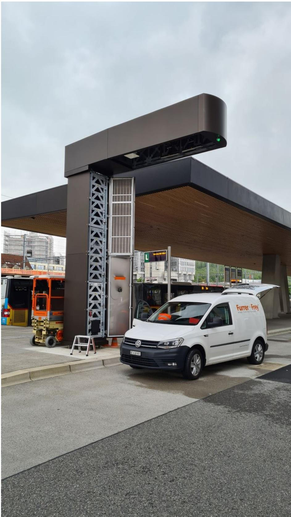
Die neue AIO Schnellladestation von Furrer+Freij passt auch optisch gut zum bestehenden Busterminal. Alle Komponenten sind integriert, die Montage einfach (Bild:
