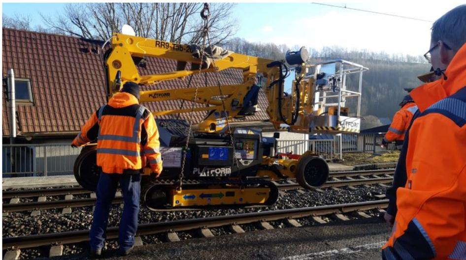
Aufgrund der Stufe zwischen Bahnsteig und dem Gleis wurde die Arbeitsbühne mithilfe eines Krans ins Gleis gehoben (Bild: Kunze).
