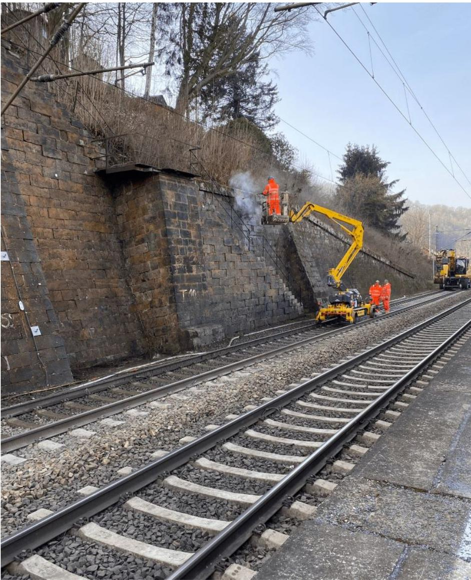
Das neue Zweiwege-Gerät wurde zur Reinigung der Schutzwände am Gleis eingesetzt (Bild: Kunze GmbH).
