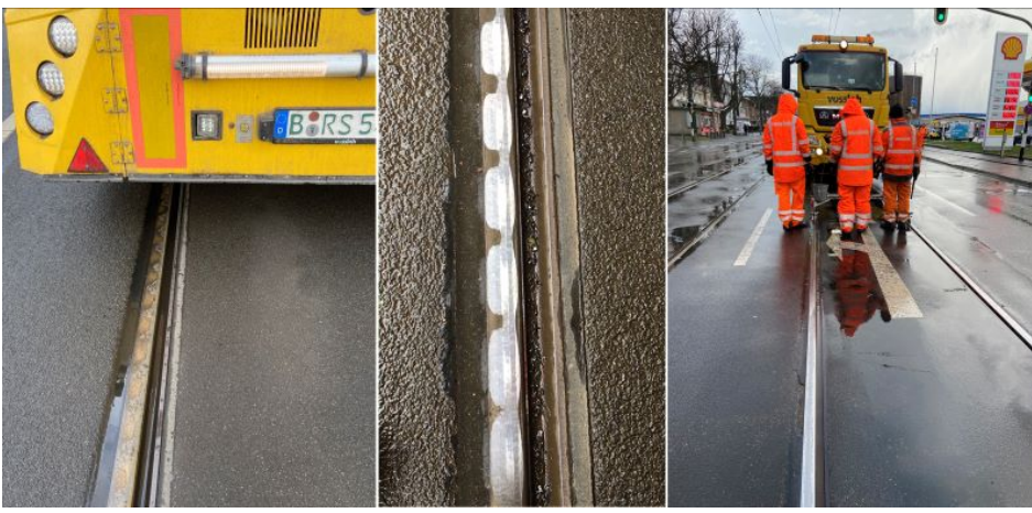
Abb. 4: Ein in zwei Überfahrten rundum erneutes, riffelfreies Längsprofil (Bild: Vossloh).
