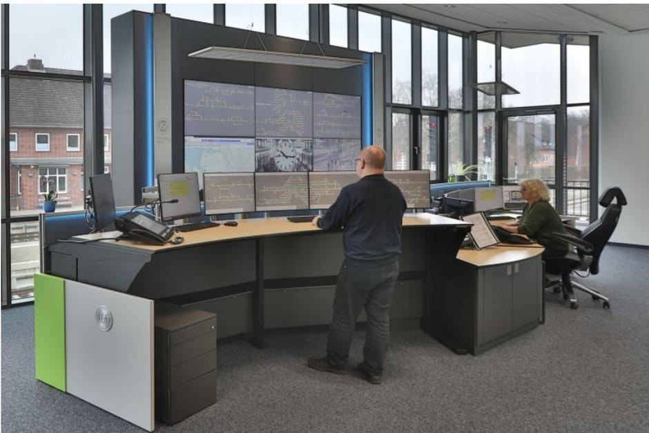
Die Kontrollraumpulte sind motorisch bis zur Stehhöhe verstellbar, so dass variierende Körperhaltungen ermöglicht und einseitige Belastungen vermieden werden (Bild: Jungmann Systemtechnik).
