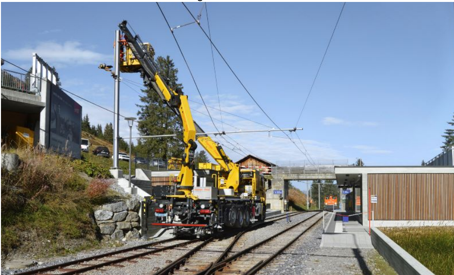
Zweigefahrzeug »SRF17« mit Arbeitskorb und Kran (Bild: Furrer+Frey).
