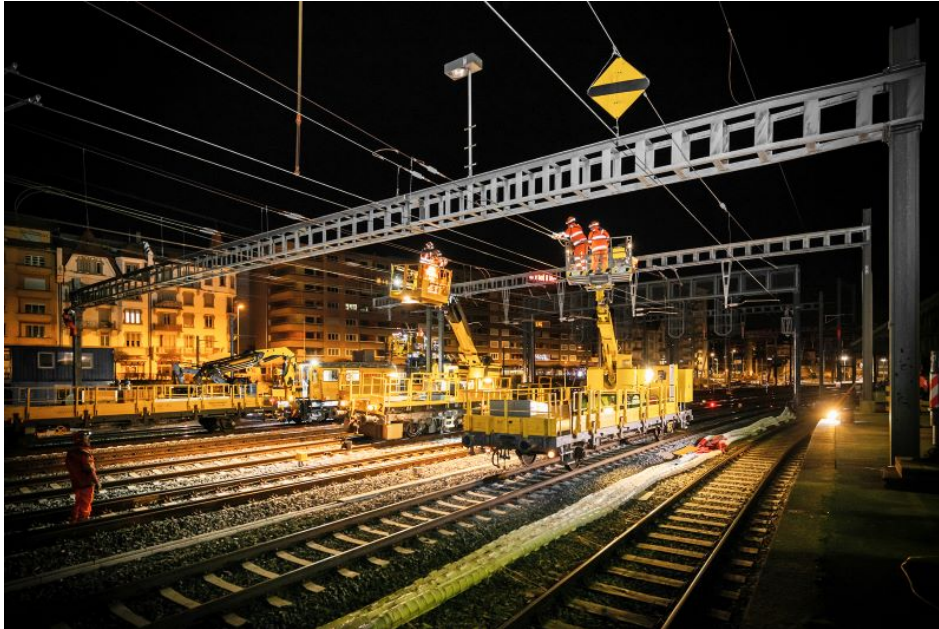
Demontage eines Jochs am Gare de Fribourg (Bild: Furrer+Frey).
