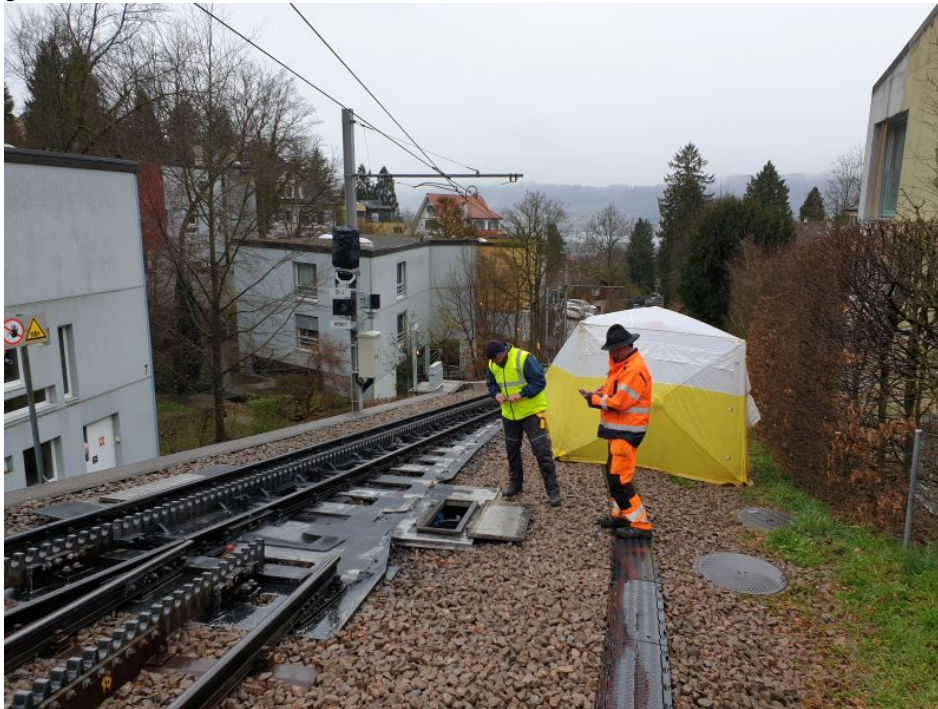
Modernisierungsmaßnahmen an einer Schwenkweiche im laufenden Betrieb (Bild: Pilz).
