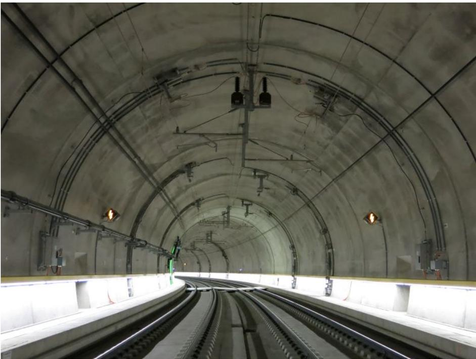
SBB-Linie CEVA, Genf: Zonenende mit Schaltgeräten und Signalen der AEE im Tunnel (Bild: Furrer+Frey).
