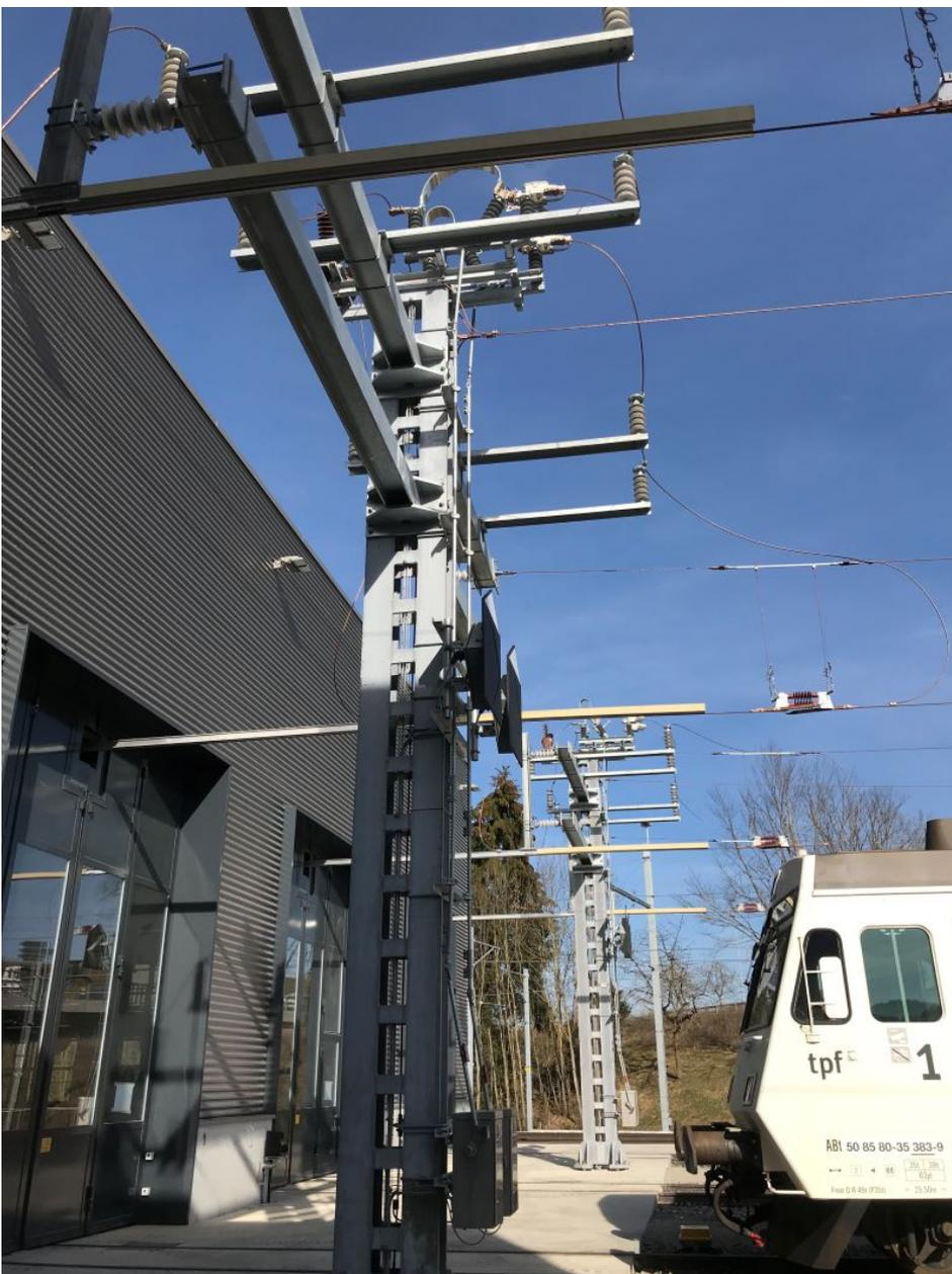
Depot der Freiburgischen Verkehrsbetriebe (TPF) in Givisiez: Abfangmasten vor Depot mit Schaltgeräten, Motorantrieben und Signalen Bedienstelle der Fahrleitungssteuerung (Bild: Furrer+Frey).
