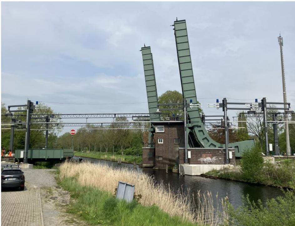
DB, Mariensiel (DE): Klappbrücken mit schwenkbarer Deckenstromschienenanlage (Bild: Furrer+Frey).
