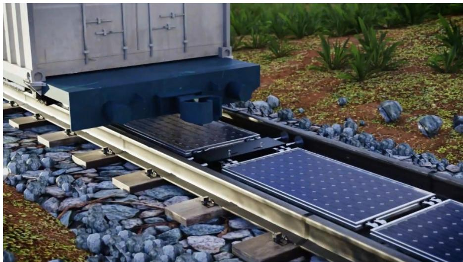
Dieses Modell veranschaulicht, wie die Solarmodule zwischen den Schienen liegen. In der Mitte sind die gespreizten Stangen sichtbar, welche die Module fixieren (Bilder: Sun-Ways).
