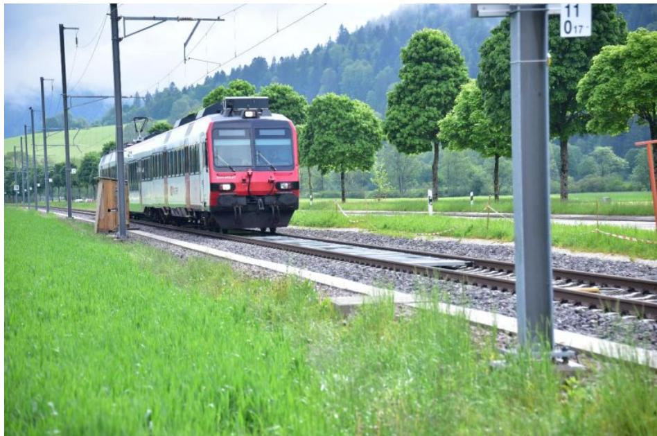
Kurz vor der Endstation der Bahnlinie Neuenburg–Buttes speisen seit Frühjahr 2025 Solarmodule zwischen den Schienen einer 100 m langen Teststrecke Strom ins Netz. Eine ältere Komposition fährt gerade darüber, links im Bild steht der Holzbau mit dem
