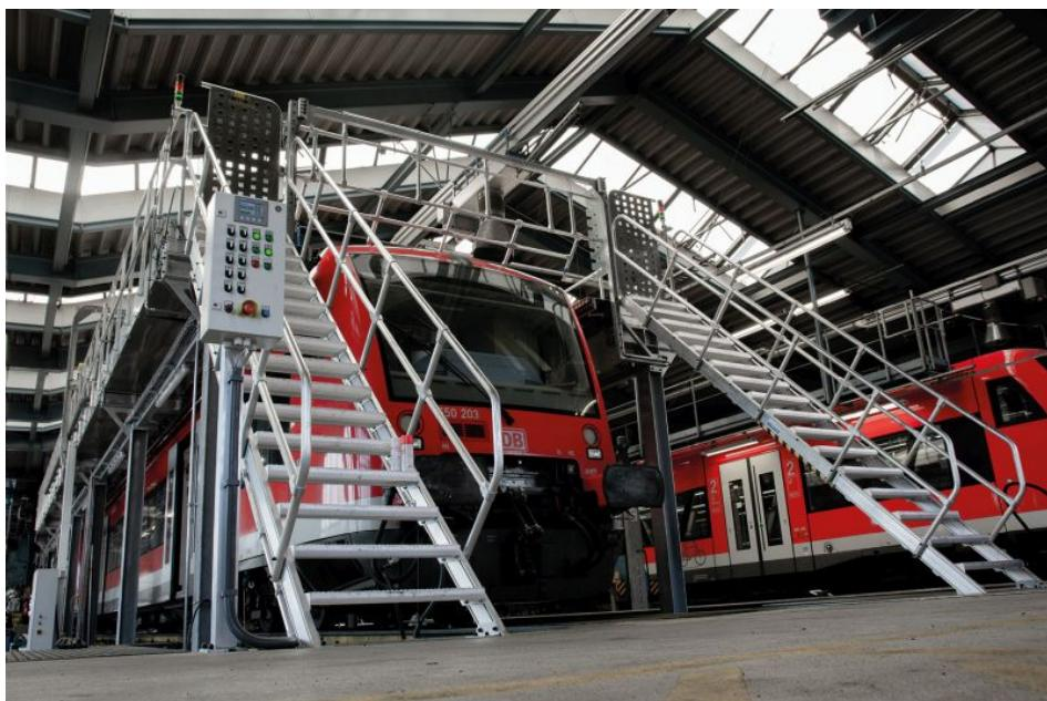
Ein Krause-Dacharbeitsstand mit beidseitigem Treppenzugang integriert in eine Wartungshalle (Bilder: Krause Werk)
